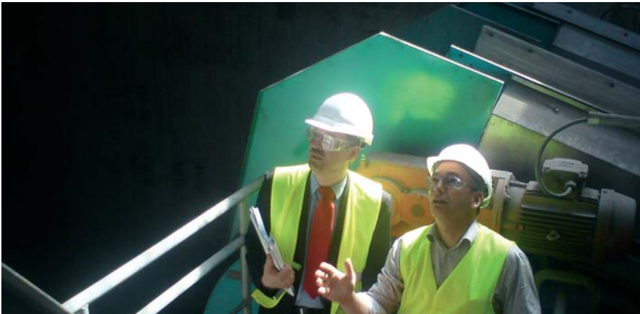
Der Leiter des MHKW's erläutert Dr. Kleesiek (links) das Schadensmaß im Schlackebunker.
